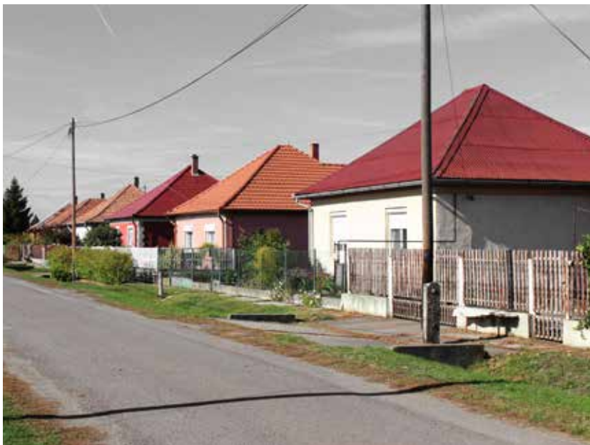
Besenyőtelek - földszintes épület
